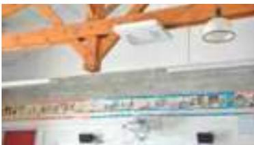
67 purificateurs d'air fixes à ultraviolets, ont été installés au printemps dernier dans les écoles maternelle Simone Veil et élémentaire Albert Jouly, pour capter et traiter l'air et le relâcher purifié. L'air en classe peut être 8 à 10 fois plus pollué que l'air ambiant
