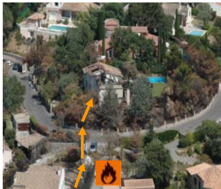
Maison de lotissement détruite par un feu de forêt. La haie du voisin a joué le rôle de vecteur.
